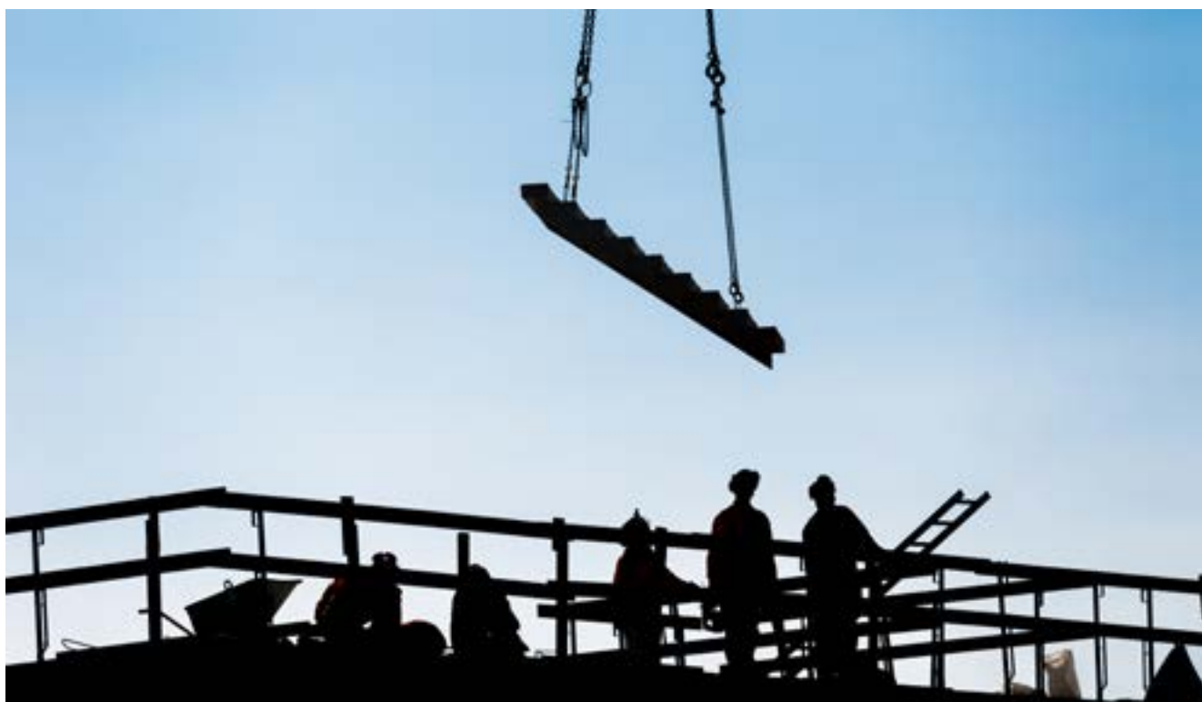
Byggeri ved Ørestad
