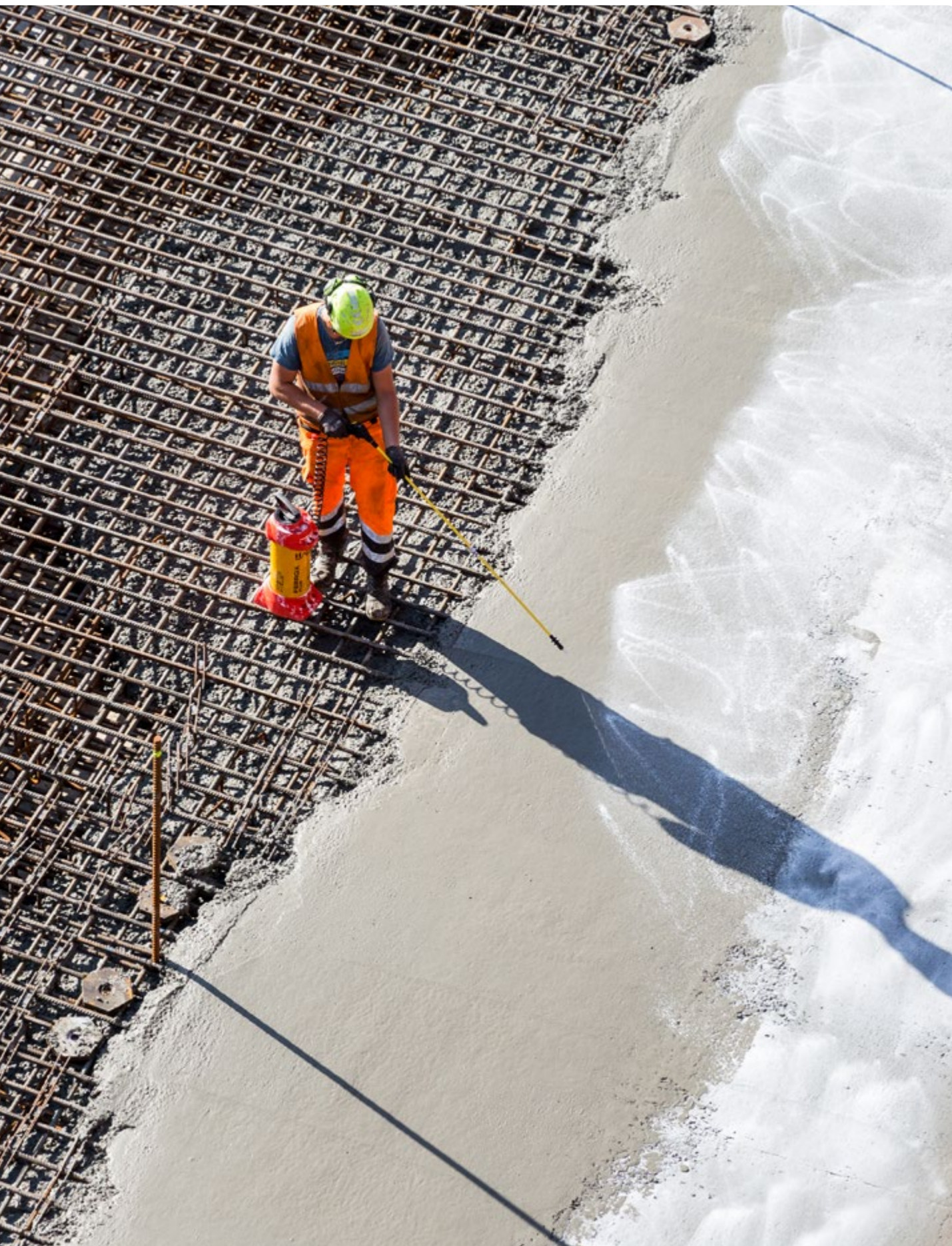
Støbearbejde på PensionDanmarks byggeri på Kronløbsøen
