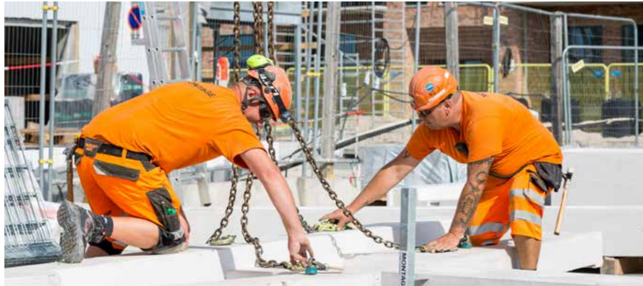
Troels og Torben med nye elementer til PensionDanmarks byggeri Sirius på Islands Brygge
