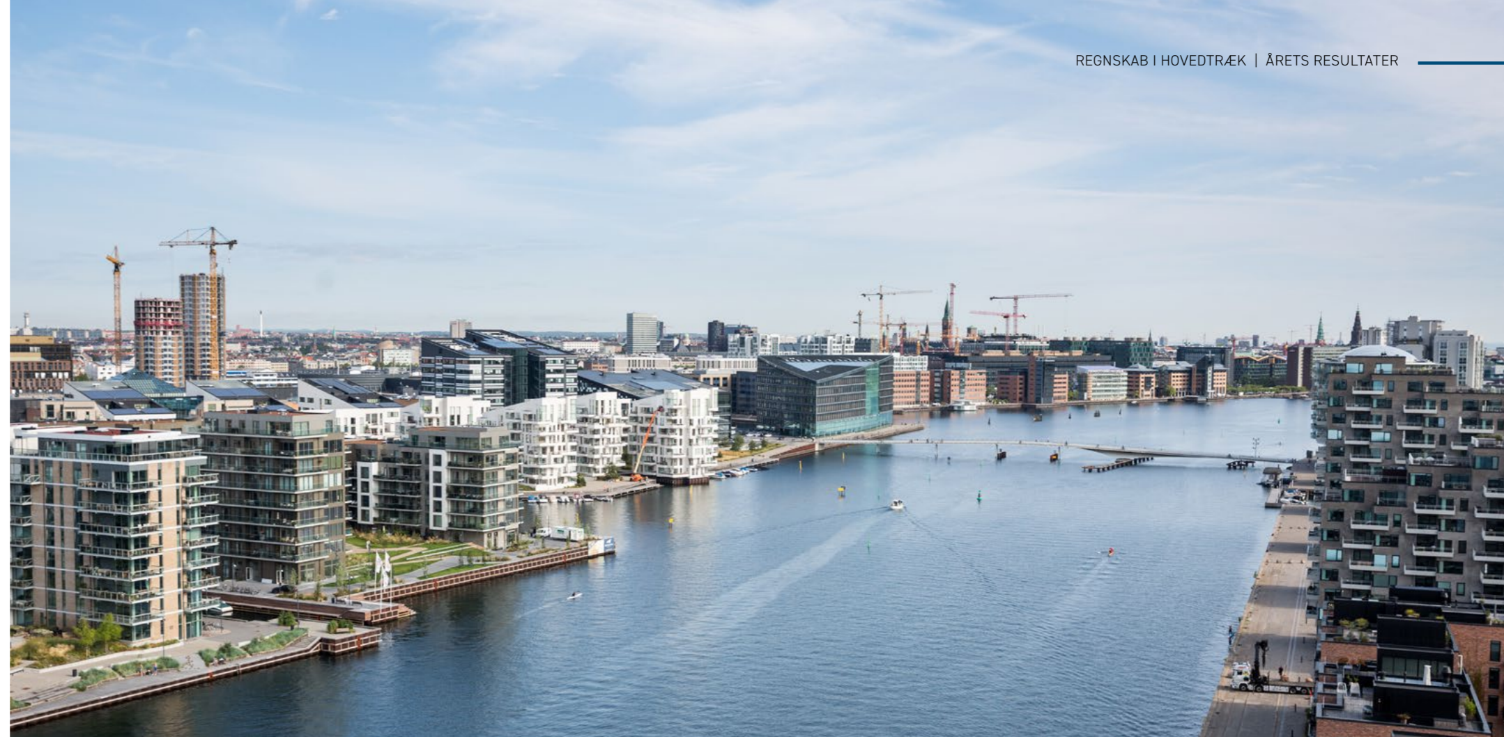
Udsigt fra PensionDanmarks byggeri af Sirius på Islands Brygge.
